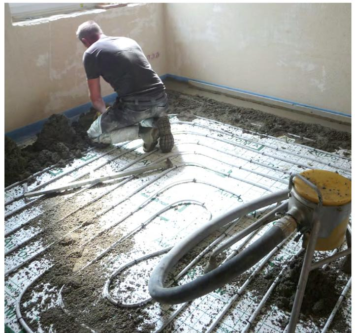
Bild 1: Einbau eines Zementestrich auf Fußbodenheizung (SCHWENK)
