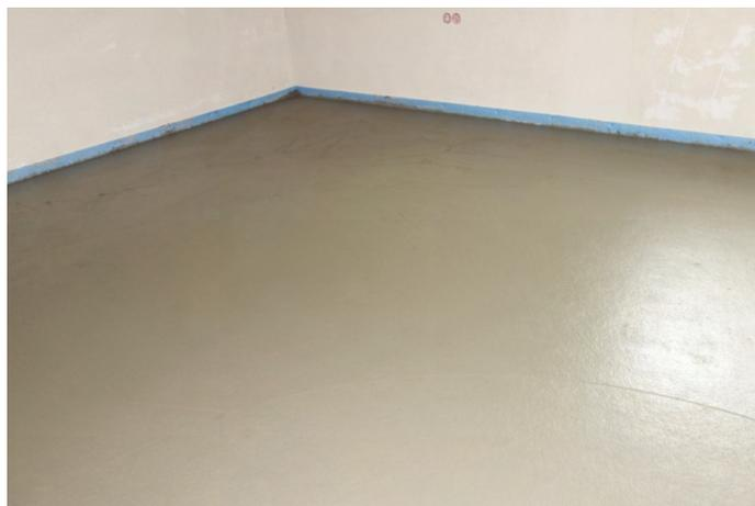
Bild 4: Fertiggestellter Zementestrich mit CEM II/B-M (V-LL) 42,5 N (az) (SCHWENK)
